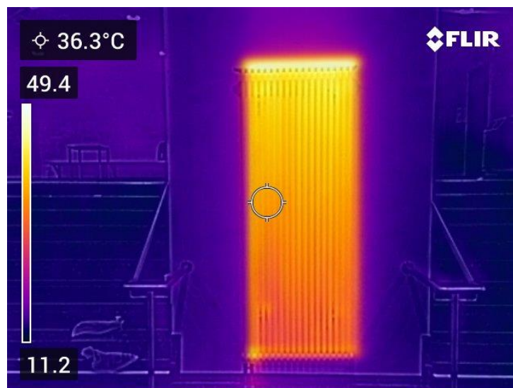
Abb.: Heizkörper im Schulgebäude
